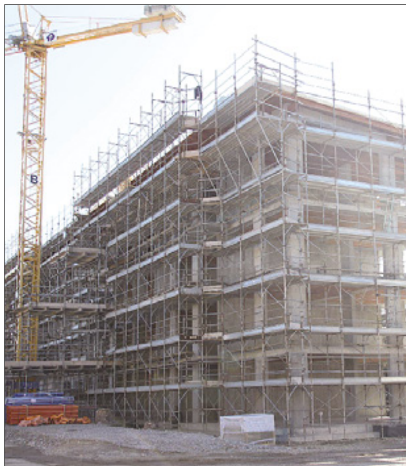
Aterjeva novogradnja v Ulici Carso na Rojcah
