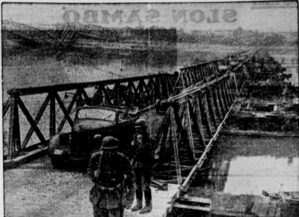
Ilustracija k premoči Nemcev nad Poljaki: Most čez Fordon pri Bidgošcu. Dolg je 360 m in so ga nemški pionirji zgradili v treh dneh. Prenese vsako obtežbo. V ozadju na levi strani most, ki so ga Poljaki ob umiku podrli.
