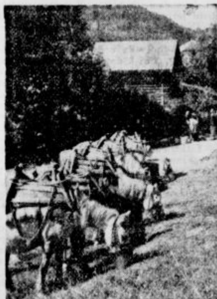
Karavana mežgov, s katerimi so Bosanci tovorili v strma pobočja cement in pesek za betonske temelje jaborov daljnovoda.
