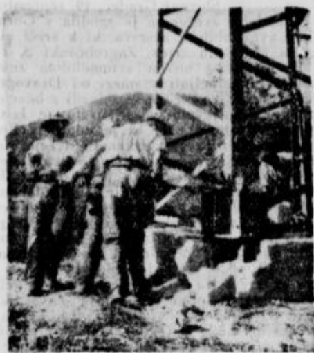
Ze postavljen železni jabor privijajo delavci z močnimi ključi na železne noge betonskega podstavka.
