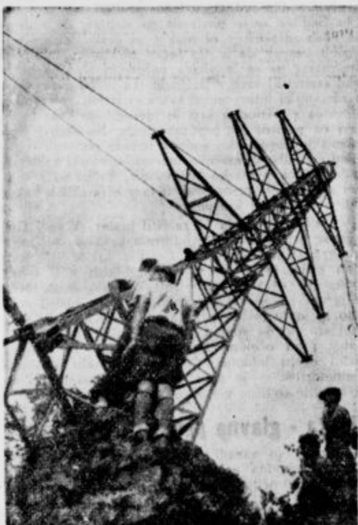
Na strmem grebenu dvigajo delavci visok železen jabor daljnovoda Trbovlje-Podlog.
