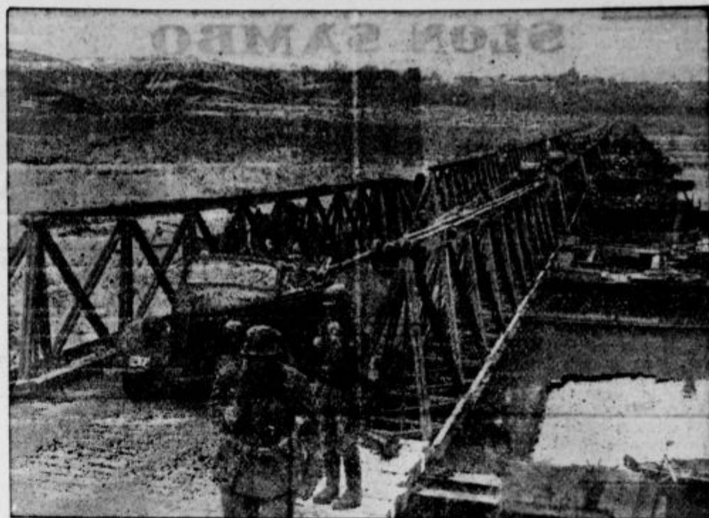
Ilustracija k premoči Nemcev nad Poljaki: Most čez Fordon pri Bidgošču. Dolg je 360 m in so ga nemski pionirji zgradili v treh dneh. Prenese vsako obtežbo. V ozadju na levi strani most, ki se ga Poljaki ob umiku podrli.
