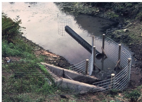
Slika 12: Levo Beaver deceiver™ in desno kombinacija s sistemom Castor master™ (foto: S Lisle)
