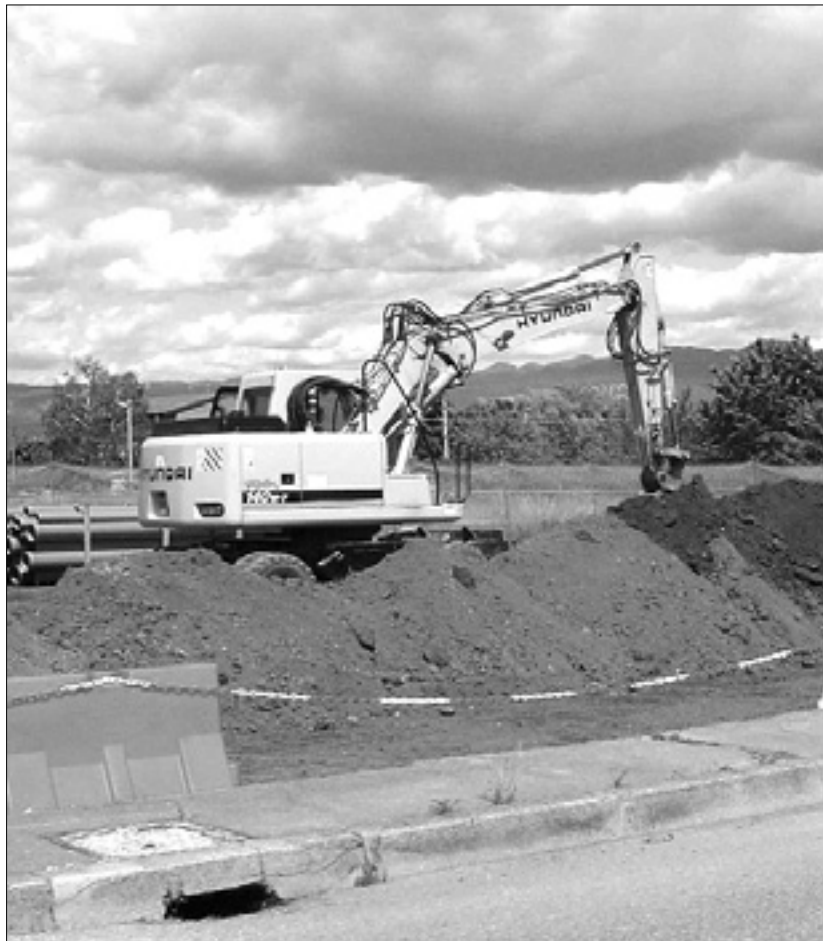
Bager na gradbišču novega štandreškega parkirišča
