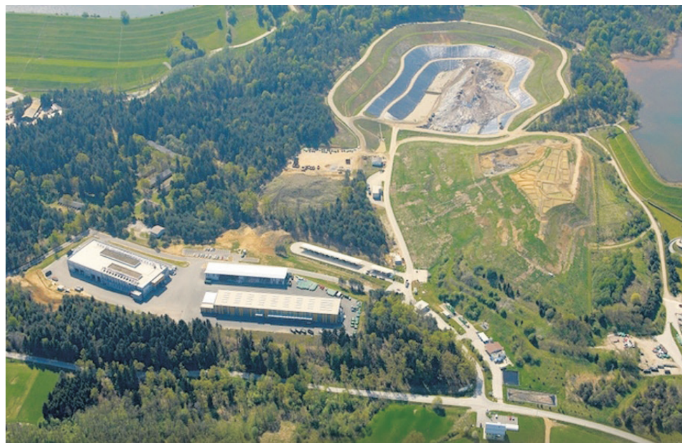
Regijski center za ravnanje z odpadki v Bukovžlaku iz zraka
