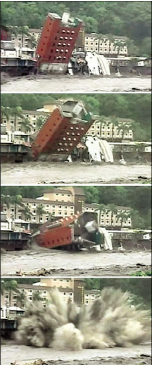
Tajfun Morakot je na Tajvanu med drugim povzročil zrušenje šestnadstropnega hotela, ki so ga k sreči pravočasno evakuirali
