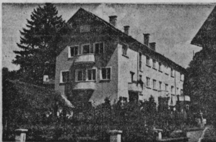
Končana zgradba Vinarske zadruge v Ptuj
