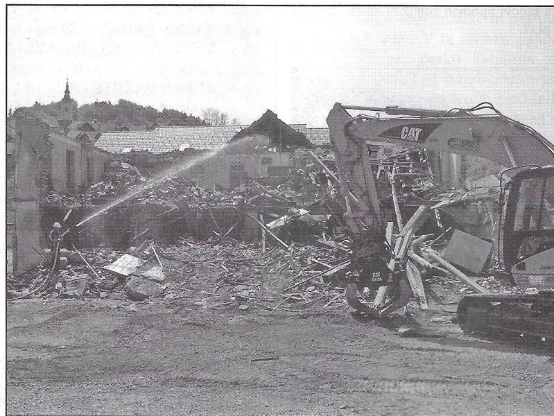
Zgradbo so ob rušenju polivali z vodo, da se ni prašilo.
