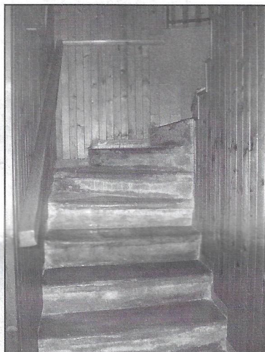
Kamnito stopnišče med pritličjem in nadstropjem
