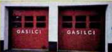
Industrijska vrata - dodatna varovanja proti požarom
