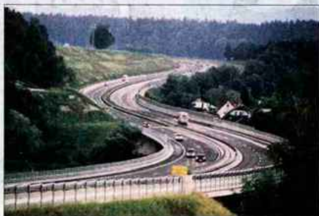
Viadukt Tržiška Bistrica (420 m) - tehnologija narivanja: hidravlika potiska iz tedna v teden daljšo prekladno konstrukcijo s stebra na stebra. Masa vsakega od obeh vozišč znaša na koncu deset tisoč ton.
