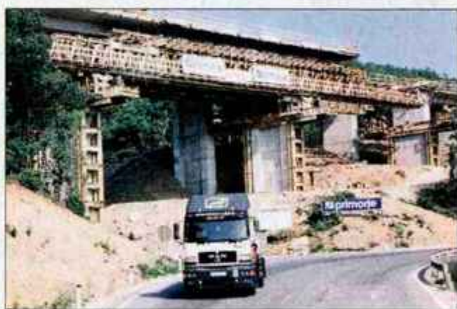
Viadukt Šumljak (673 m) na klanecu Rebernice - gradnja s pomočjo drsnega opaža je zahtevna in tehnološko zanimiva.
