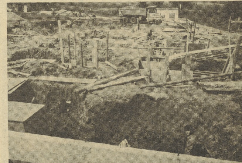
TOZD ELEKTROLITSKI KONDENZATORJI MOKRONOG: Gradnja nove tovarne dobro napreduje. Na sliki: na gradbišču v do deset metrov globokih gradbenih jamah betonirajo tako imenovane točkovne temelje.
