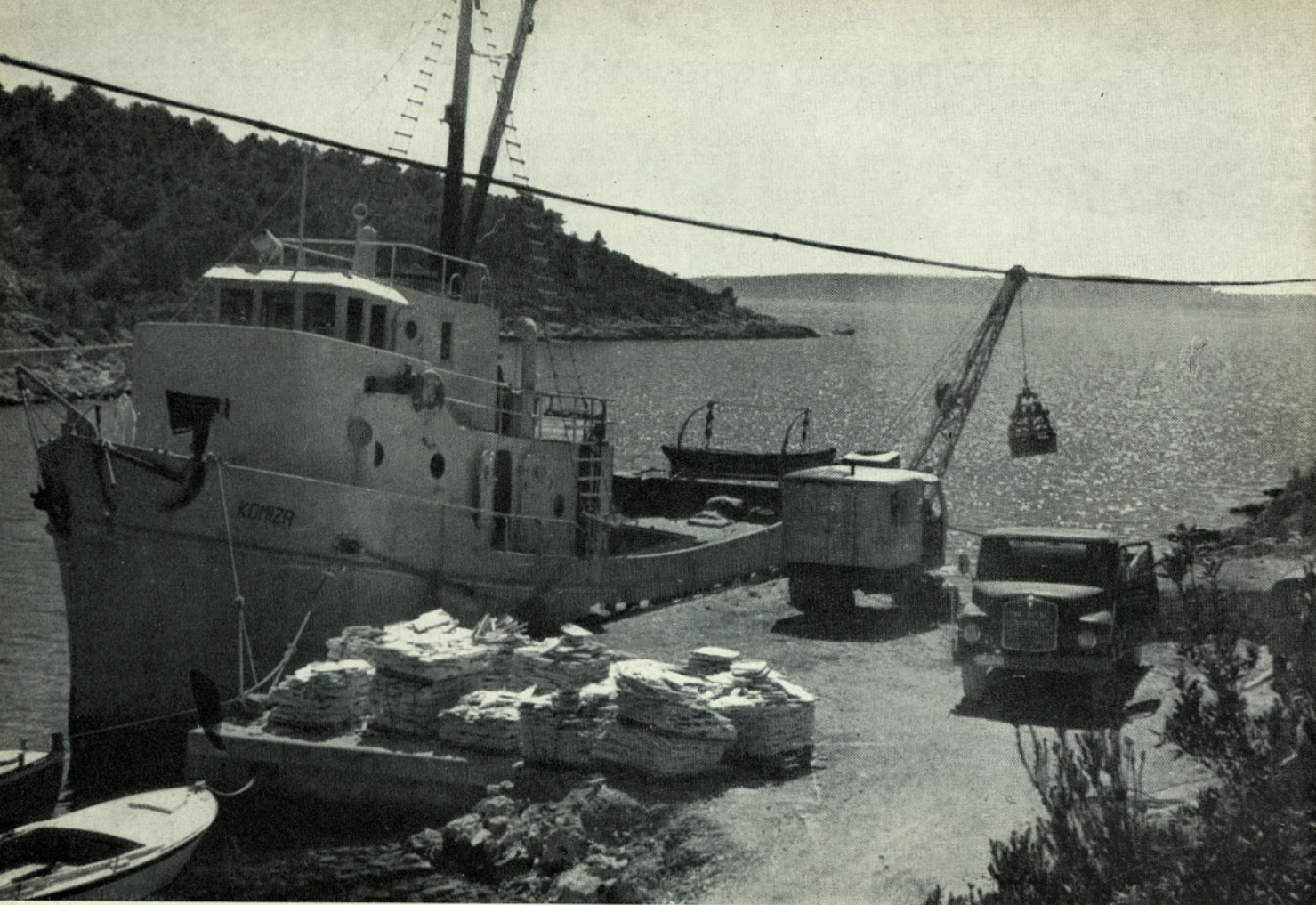
Prevoz materiala na gradbišču na Hvaru
