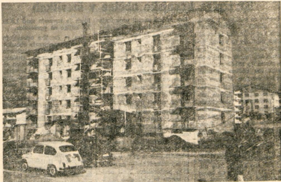
V Groharjevem naselju v Skofji Loki delavci podjetja Tehnik iz Skofje Loke dograjujejo nov 30-stanovanjski blok, ki bo predvidoma vseljiv v juniju. Nekaj stanovanj je še naprodaj. — Foto: F. Perdan
