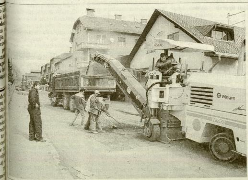
V torek so delavci podjetja Ceste mostovi Celje preplastili del Delavske in Kovinarske ulice, po katerih bo do konca julija speljan obvoz za osebna vozila.
