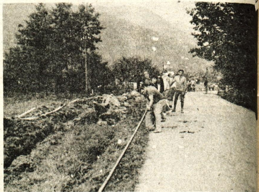
V sredo, 22. avgusta, so krajani v smeri proti Česnjemku polagali kabel glavni telefonski vod. Strojni izkop v tej akciji je vodil predsednik krajevnih skupnosti Velesovo Anton Ropret, vodja gradbenega odbora v delovni akciji pa je Milan Sajovic iz Velesovega.
