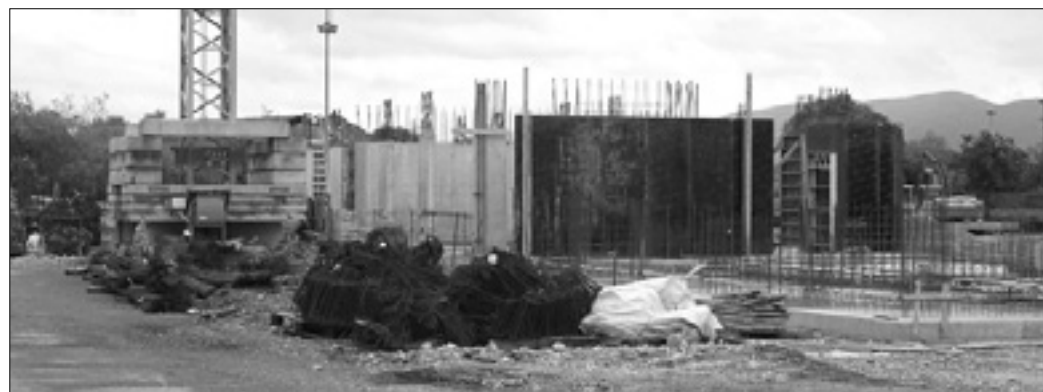
Gradbišče v Ulici Carso
