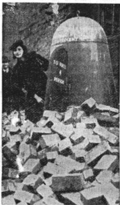
Jekleno zaklonišče v Birminghamu je ostalo pri poskusnem bombnem napadu popolnoma nepoškodovano. V njem je prostora za štiri osebe.
