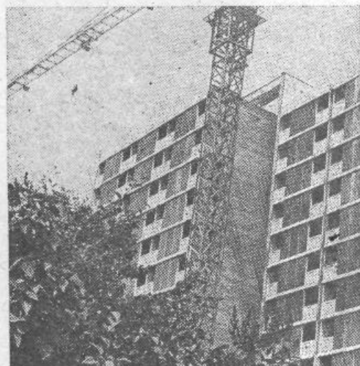
Nedružinska stanovanja ob Celovski cesti...
