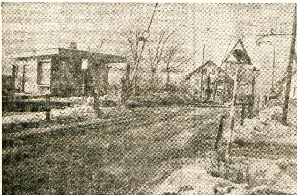
Na severni strani železniške postaje v Zirovnici zapirajo promet moderne zapornice. Ko se približuje vlak, začne utripati rdeča luč, zapornice pa se precej hitro spuste. Naprava je vključena v električno signalno varnostno napravo postaje v Zirovnici, od koder jo avtomatsko upravlja prometnik. — Foto: B. Blenkuš
