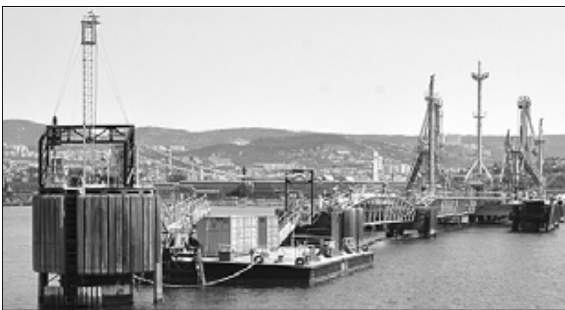
Morski terminal naftovoda SIOT, ki povezuje Trst z Bavarsko
