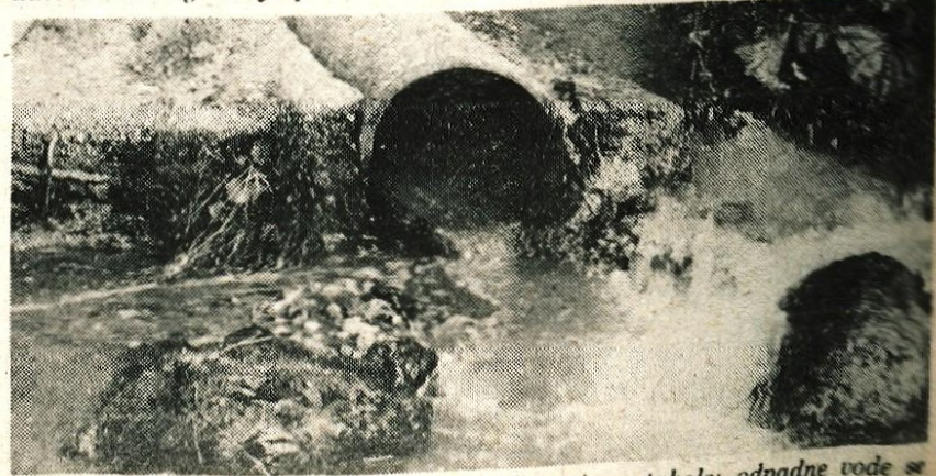
Kanalizacija na Ravnah je zdaj urejena takole: odpadne vode se stekajo v potok in ga onesnažujejo. Prihodnje leto bo predvidoma zgrajen kanal S. Dokumentacija je že pripravljena, dela pa bodo zahtevala okrog 6,5 milijona dinarjev.
