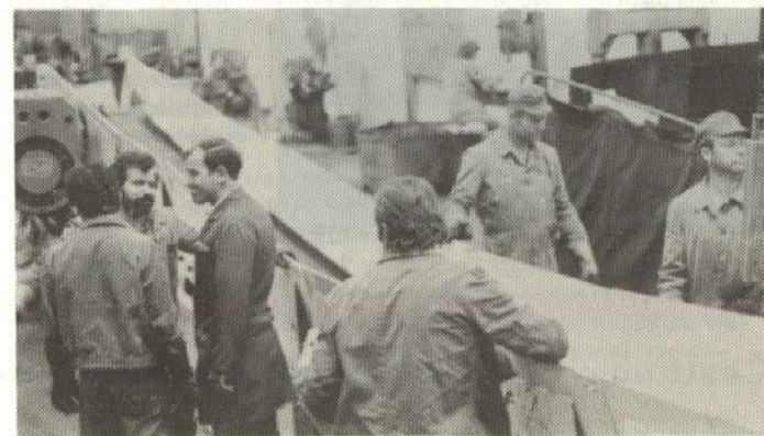
ELEKTROSTROJNI OBRATI - ELEKTROSTROJNA OPREMA
