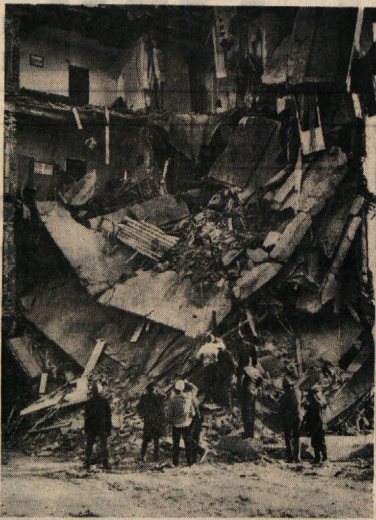
Strahotne posledice potresa v Banjaluki: ena od najtežje poškodovanih stavb «Titanik» v samem središču bosanskega mesta
