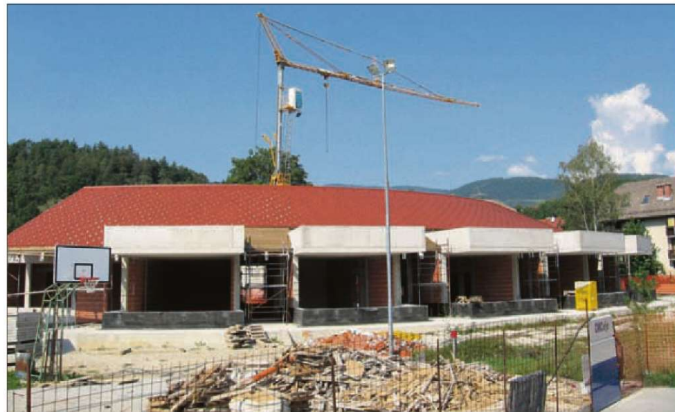
Tako je izgledalo na gradbišču novega vrtca na Dobrni konec poletja, ko se je družba CMC morala posloviti. Dela so zamujala.
