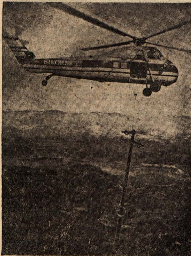
Helikopterji so pomagali graditi tri milje dolg daljnovod z napetostjo 12.000 voltov čez kalifornijski Narodni park Los Padres. Kako je to šlo, kaže slika
