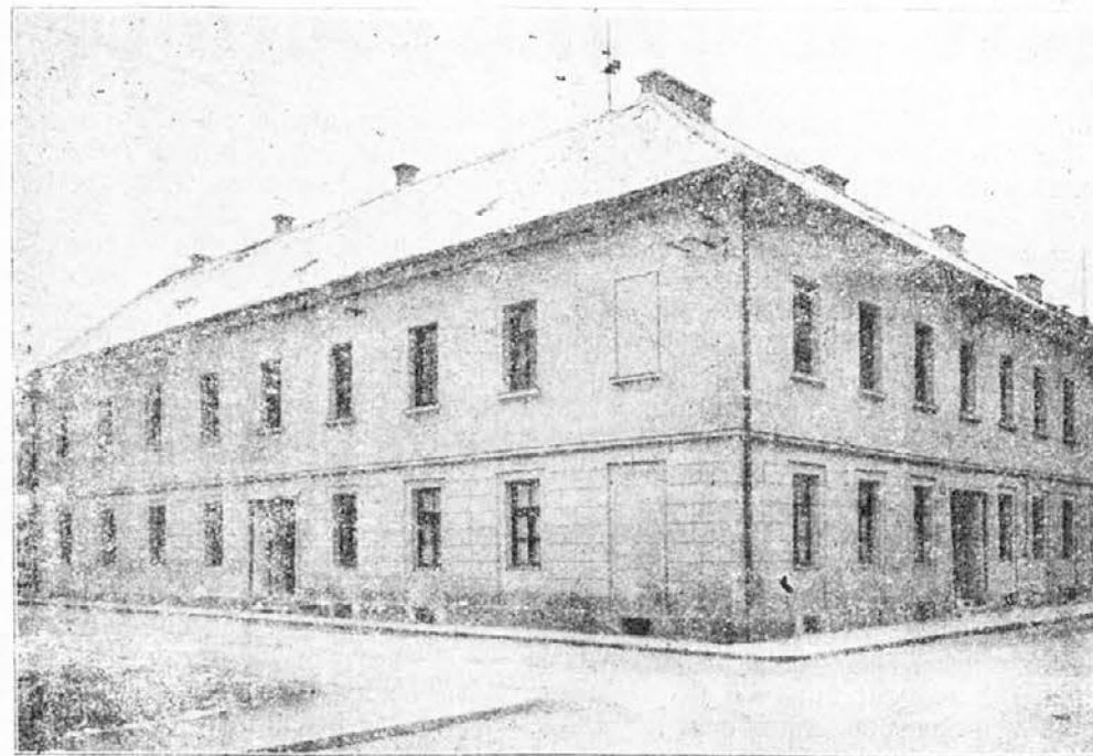
Poslojpe Delavske zbornice v Celju.
