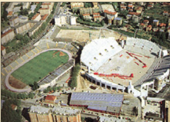
V knjigi je tudi posnetek gradnje tržaškega štabiona Rocco
