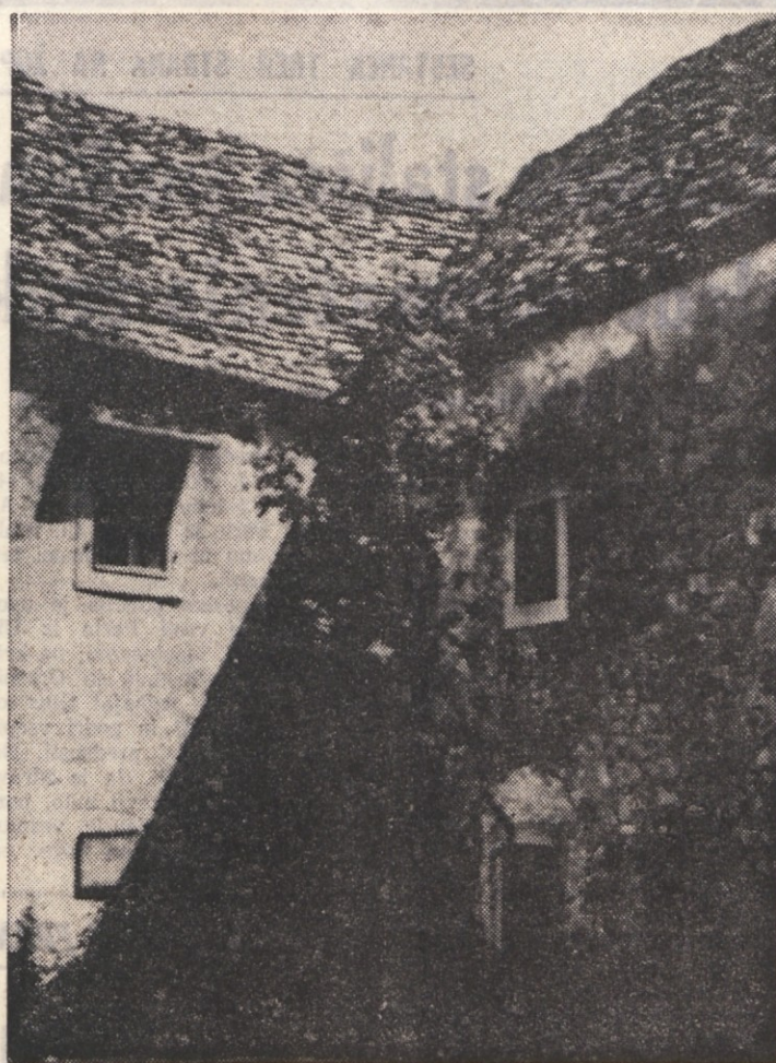
Skrliste strehe na starih kraških domovih. Na sliki skrlasta streha v Repnu
