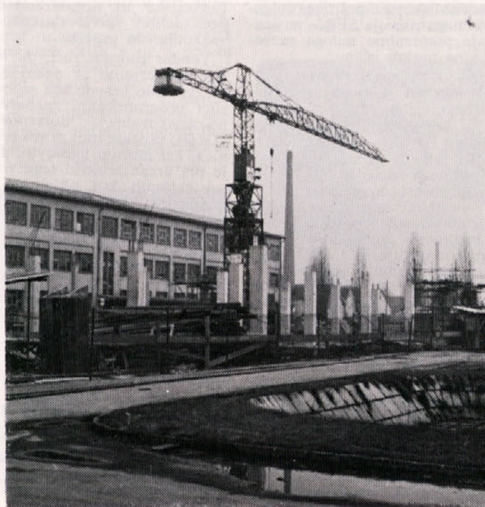
Gradbišče skladišča gotovih izdelkov
