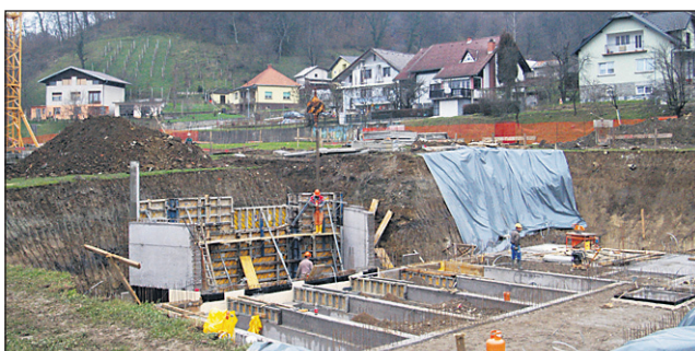
Gradbeni delavci podjetja Konstruktor VGR že betonirajo temelje bodočega kulturno-prosvetnega centra.
