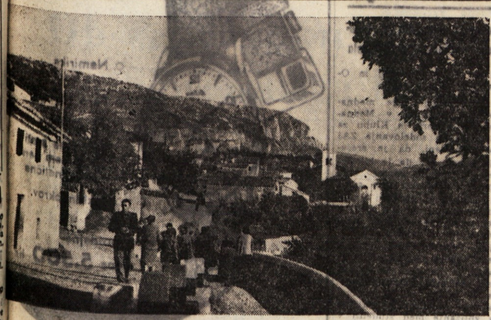
Pogled na del Boršta
