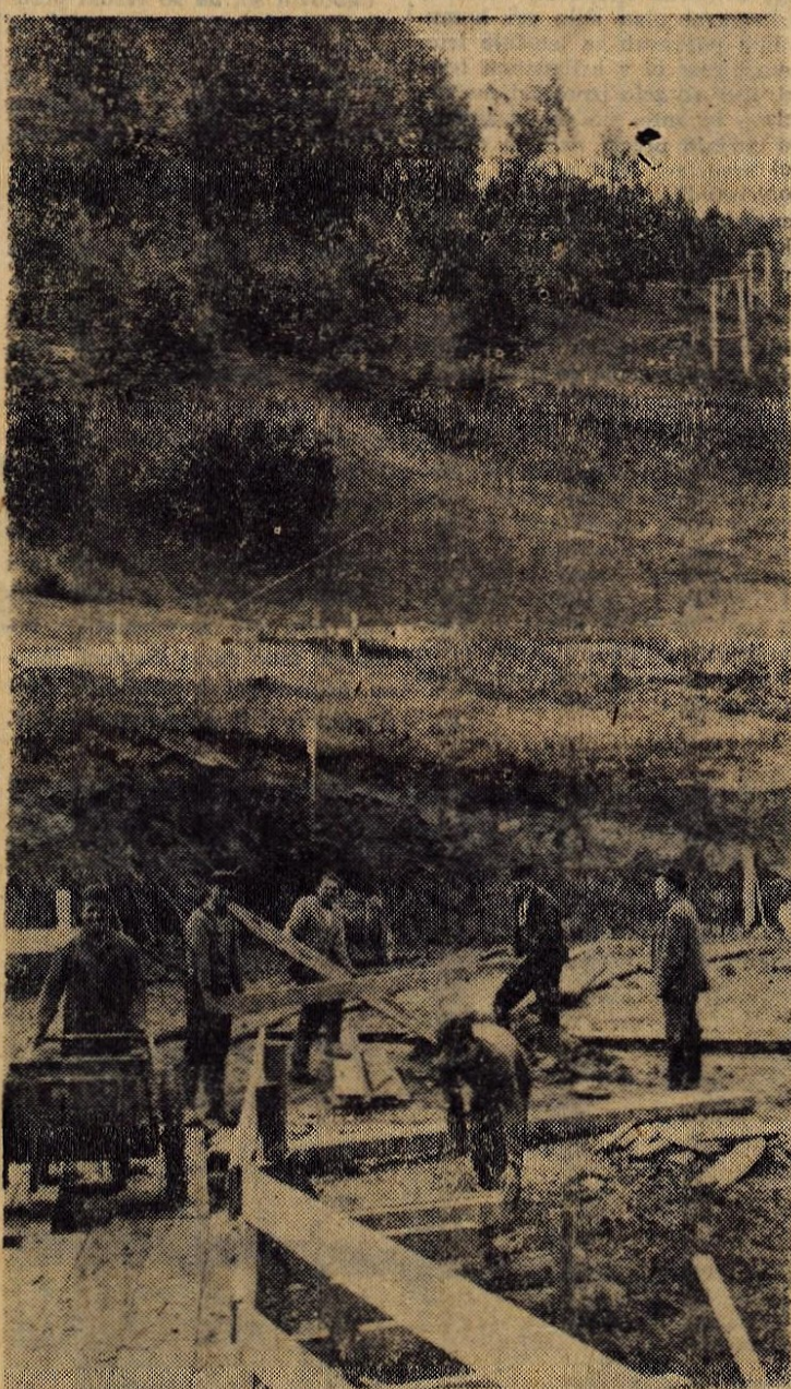
Žičnica s Planine pod Golico na Črni vrh ni več samo želja. Posnetek prikazuje začetek gradnje spodnje postaje žičnice. Ta bo velikega pomena za turizem in predvsem za zimski šport v tem predelu
