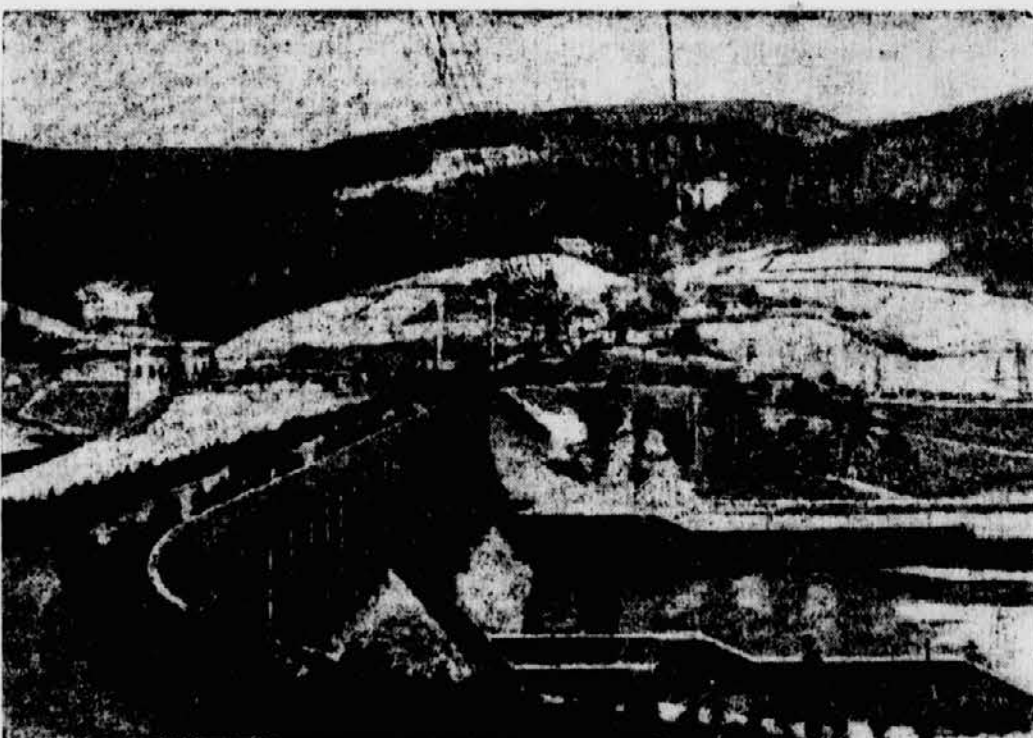
In Potembla an der Sola (Kreis Krakau) wurde ein großes Wasserkraftwerk eingeweiht. Das 7 Kilometer lange Staubecken hat ein Fassungsvermögen von 32 Millionen Kubikmeter, während das Werk eine Leistungsfähigkeit von 37 Millionen Kilowattstunden erzeugen kann. Des ist eine Uebersicht des Kraftwerkes während der Einweihungsfeier. (Scherl-Bilderdienst-M.)
