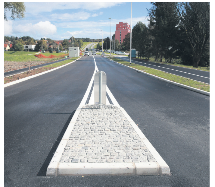
Pogled na nov del severne vezne ceste in naselje Nova vas.
