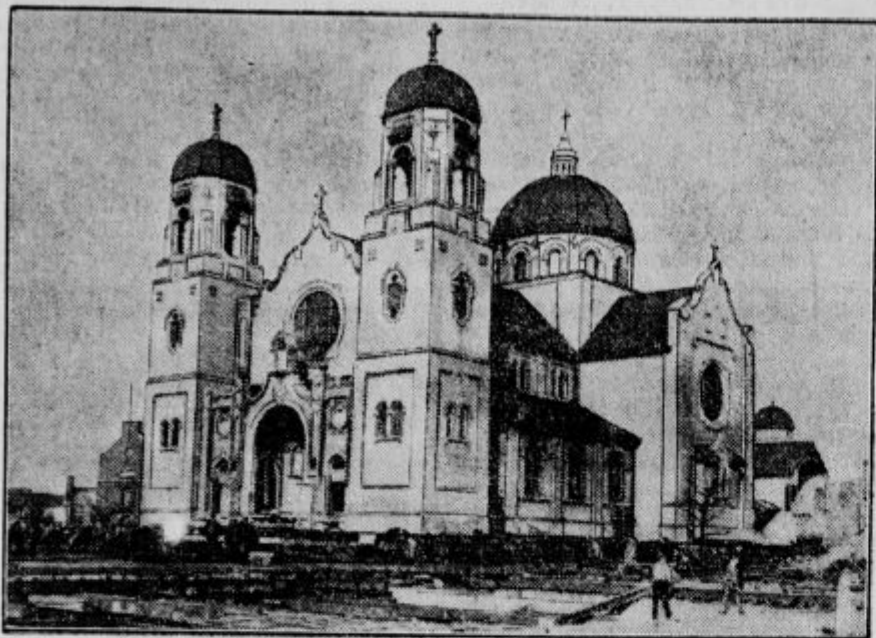
Cerkev Notre Dame v Chicagu so premaknili z ene strani ceste na drugo, ker je ovirala promet. Zelo drzen poskus, nadomestiti temelje cerkve s premikajočimi se valjarji, se je sijajno posrečilo.
