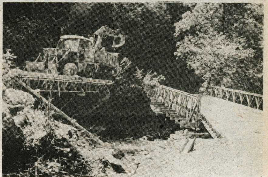
Most v Jelendolu dobi le še fini asfalt — Konec avgusta bi moral biti dokončan most čez Tržiško Bistrico, ki ga je gradil SGP Tržič. Pa so se dela zavlekla, a bo zdaj zdaj dokončan. Cestno podjetje je te dni čez most že položilo grobi asfalt, prihodnji teden pa še finega in most bo nared. — Foto: D. Dolenc
