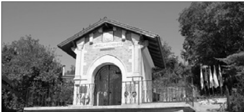
Madžarska kapelica pri Vižintinih
