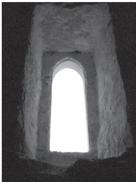
V kapeli so zdaj »odprli« zazidano gotsko okno.
