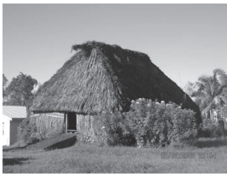
Tradicionalno izdelana hiša iz naravnih materialov - posušenih listov bambusa in trave.
