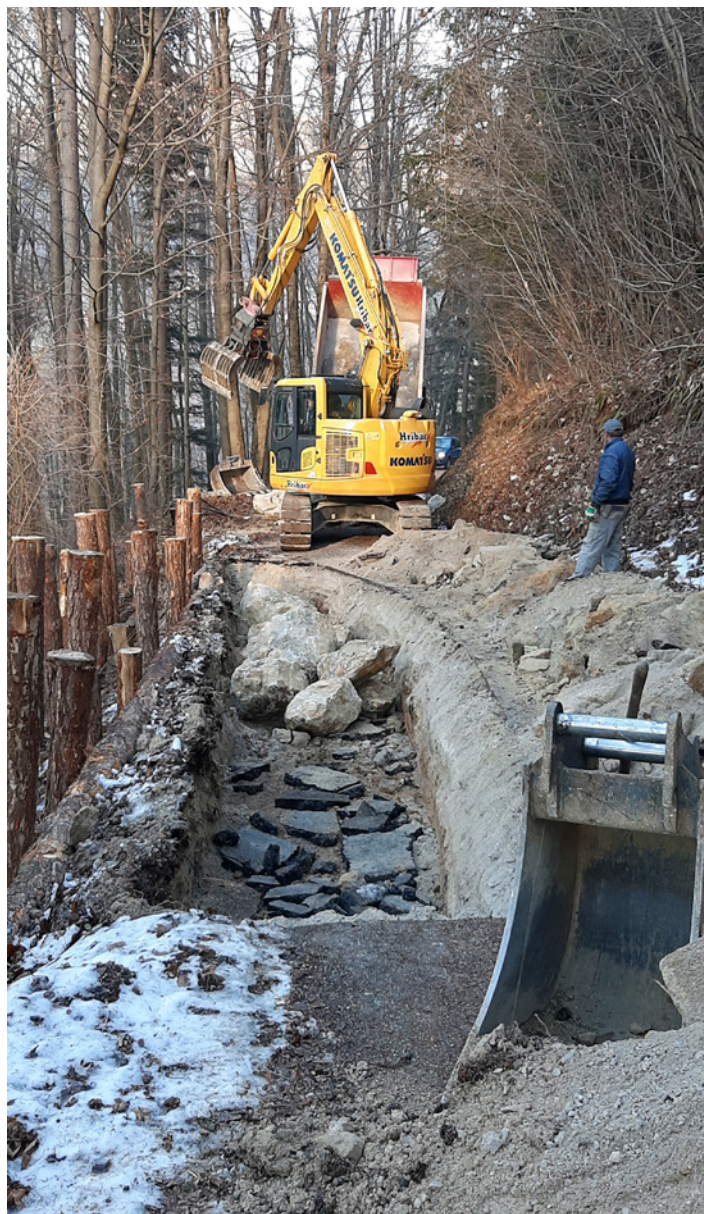
Sanacija usadov na cesti Podmilj–Samoglar in ureditev meteornega odvodnjavanja.
