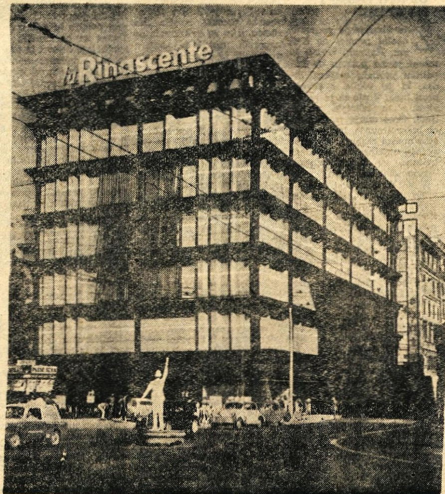
SKLADNA ARHITEKTURA IZ BETONA IN STEKLA NA RIMSKEM TRGU. PALAČA RINASCENTE, KI STA JI NAČRT NAPRAVILA ALBINI IN HELG, SPADA V VRSTO REPREZENTATIVNIH STAVB V SODOBNI ITALIJANSKI ARHITEKTURI.
