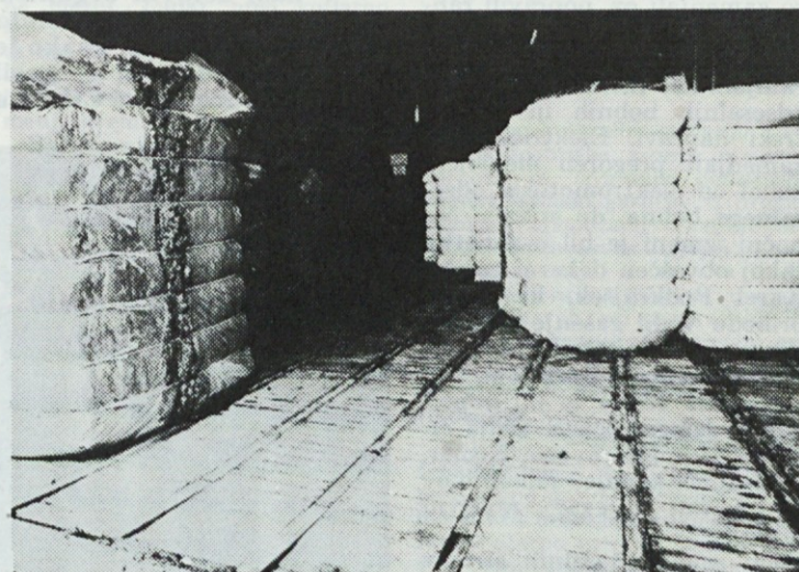
V objektu je zaradi vode poškodovan parketni pod.
