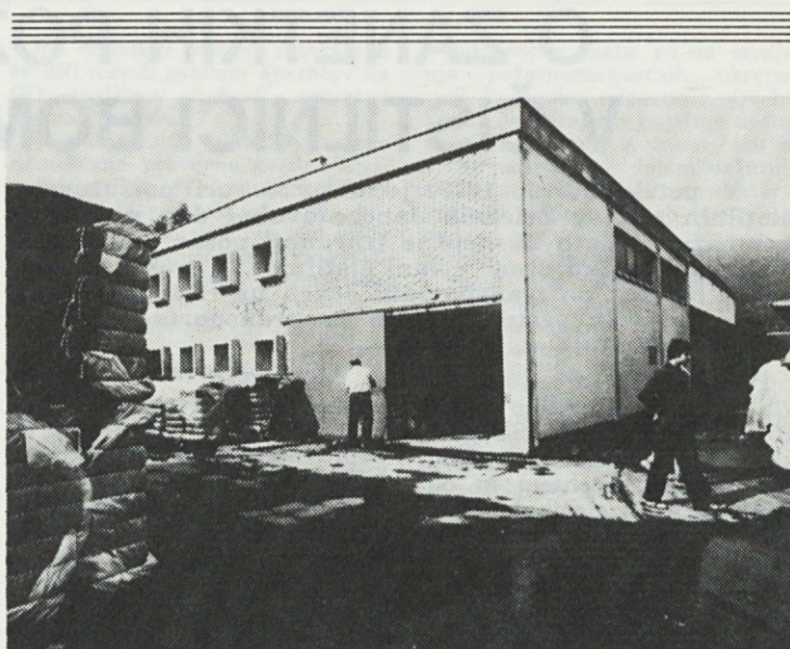
Zaradi hudega naliva 26. 6. 1979 je voda vdrla izpod vhodnih vrat v predmešalnico vlaken.
