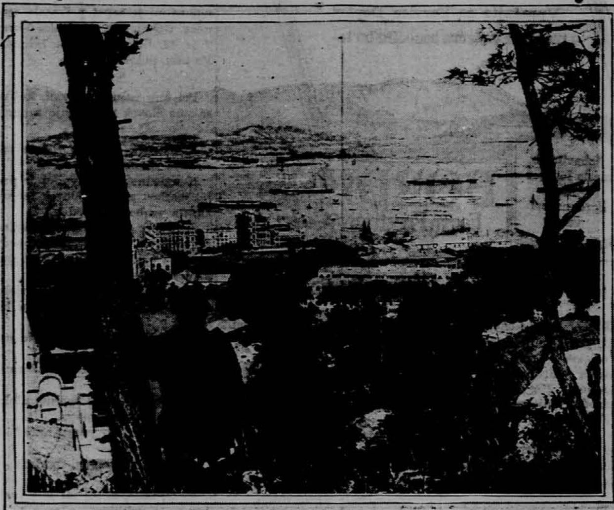
Slika nam kaže del kitajskega pristanišča Hong Kong, kjer je povzročil zadnji vihar neizmerno škodo. Nad petsto ljudi je bilo ubitih, na tisoče poškodovanih, na stotine jih je pa brez strehe. Izvanredno močno je divjal vihar tudi ob korejski obali.
