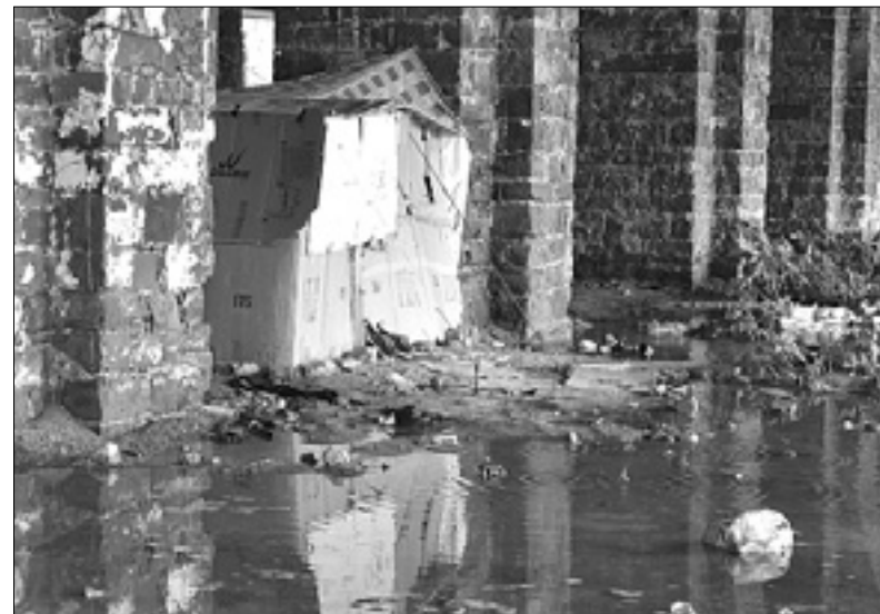
Silos je preplavila voda
