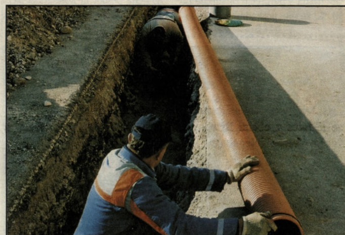
Pri polaganju cevi sanitarno tehnološke kanalizacije
