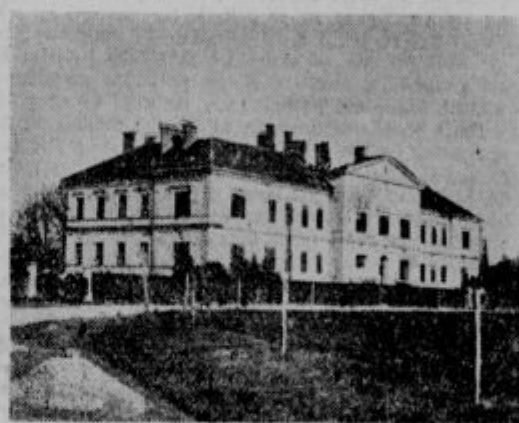
Pogled na pročelje brežiške bolnišnice. V ozadju mole v zrak goli dimniki, kjer je zgorelo ostrešje.
