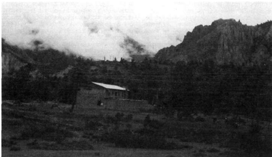
Mimo teče elektrika, v šoli pa ni toka
