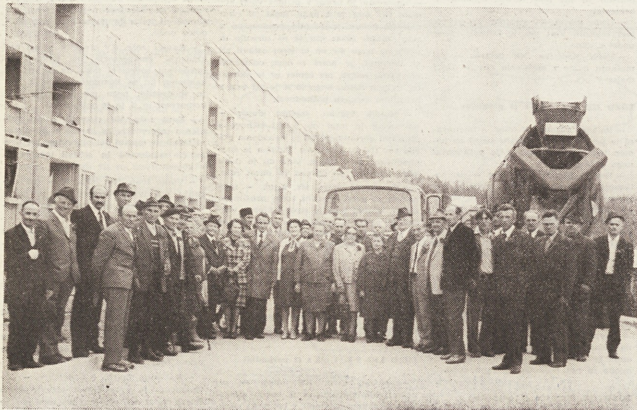
Naši bivši sodelavci so si ogledali tudi nekaj gradbišč
