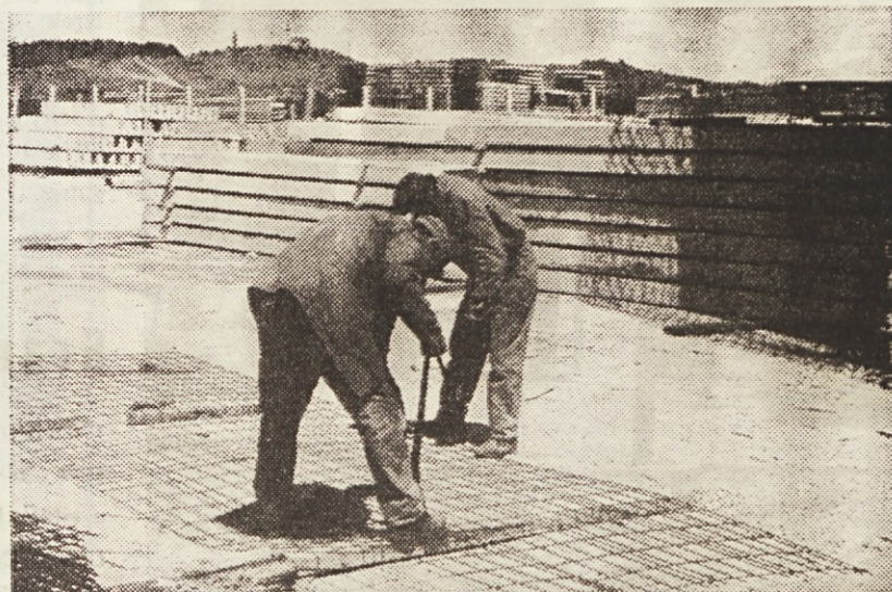
Izdelava armaturne mreže na OBI
