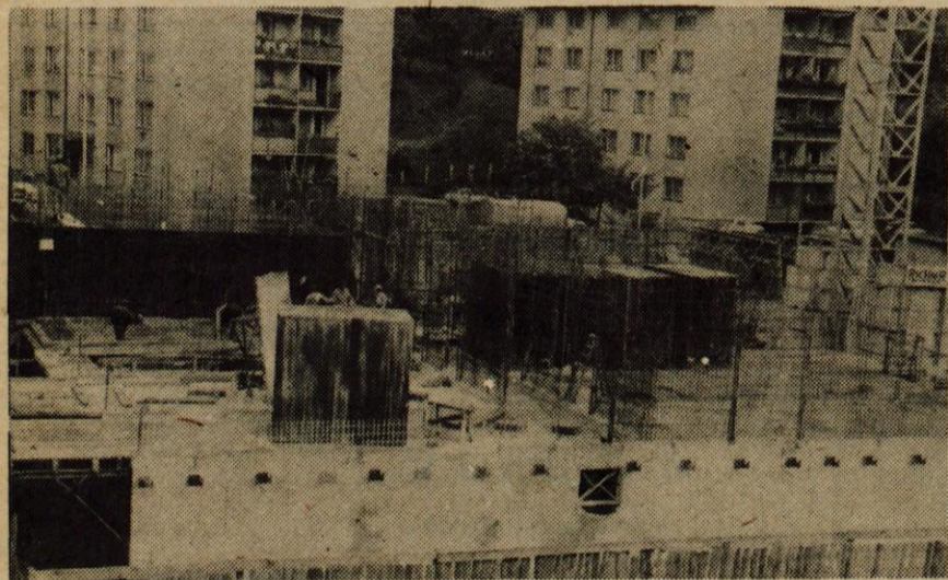
Delavci SGP Sava Jesenice so lani zahodno od poslopja Elektro Žirovnica odstranili dvostanovanjsko Votkovo hišo in na istem kraju začeli graditi novo 12-nadstropno stolpnico. Zcradi talne vode so morali najprej izsušiti teren in vgraditi v temelje 60 nosilnih stebrov. Zdaj že gradijo stolpnico S 1, kjer bo 91 družbenih stanovanj. Stanovanja bodo zgrajena predvidoma do prihodnje pomladi. Graditev stolpnice sodi v srednjeročni program stanovanjske gradnje, po katerem je letos predvidenih 266 stanovanj, prihodnje leto pa 199. — B. B.
