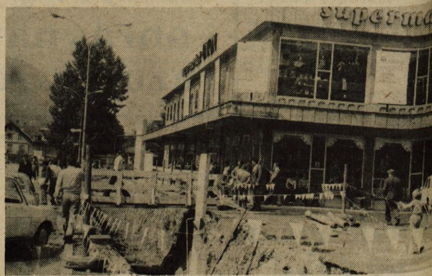
Jesenice so prav ta čas prekopane po dolgem in počez, saj so v teku velika gradbena in instalacijska dela. Medtem ko delavci Cestnega podjetja Kranj in SGP Projekt modernizirajo magistralni del ceste od Javornika do doma TVD, pa delavci Kovinarja istočasno grade novo kanalizacijo. Razen tega pa se gradi še nov toplovod za ogrevanje stanovanjskih in poslovnih stavb od jeseniške gimnazije pa vse do potoka Jesenice pri Spodnjem Plavžu. Zaradi novega toplovoda so v Železarni zgradili nov dimnik, jeseni pa čakajo še nov kotel, ki naj bi prišel iz Zagreba. — B. B.
