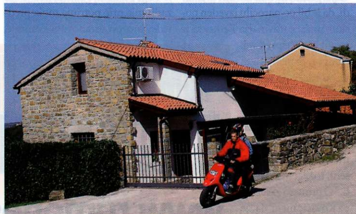
Urejena primorska stanovanjska hiša Marka Pavlihe, Sveti Peter 65 A pri Sečoveljah, je na zunaj precej podobna drugim v teh krajih, vprašanje pa je, kaj skriva notranjost.
