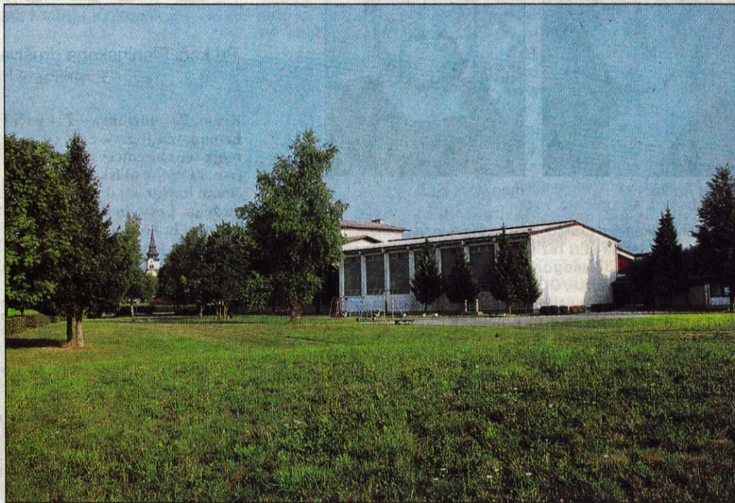
Prilavljajo se na obnovo šole in gradnjo prizidka.
