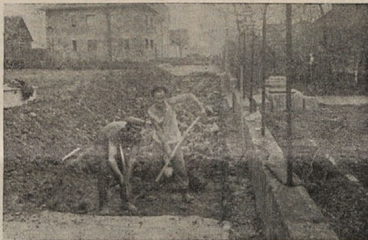
Pred kratkim je začela kočevska Komunala prenavljati Prešernovo cesto. Obnovljena cesta bo široka 5 m (kot sedanja), bo asfaltirana, imela bo robnike, bo brez pločnikov, na desni strani bo imela 3 m širok zelen pas, v katerem bodo tudi vse napeljave (cevrovod, električni kabel in ostali priključki). Cesta bo predvidoma dokončana do 1. avgusta letos.
